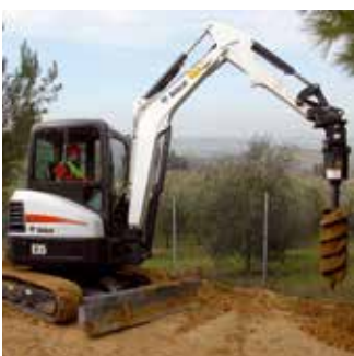
Bobcat E35 mit Erdbohrer 15c
